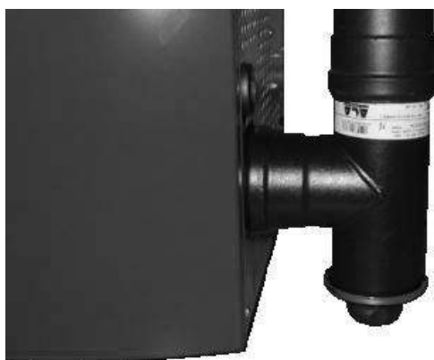
Fig. 29 - Reinigung des Rauchgaskanals
